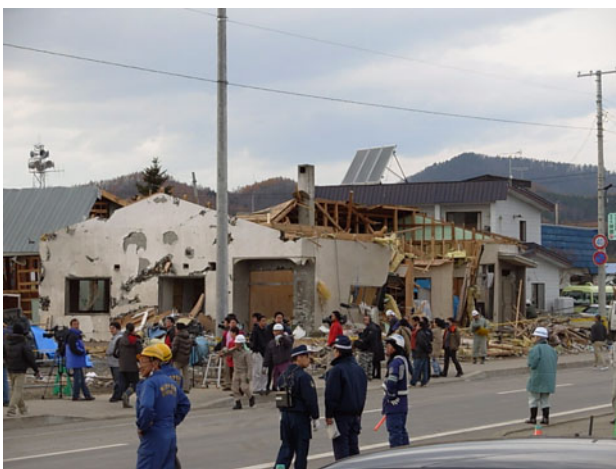
写真 14 事務所併用住宅の被害
