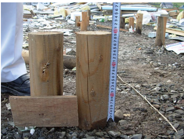
写真10 木ぐい (C棟)
