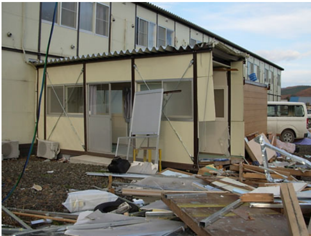
写真 12 B 棟と C 棟をつなぐ渡り廊下
