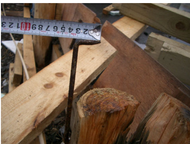
写真8 木ぐい側に残ったかすがい (A棟)
