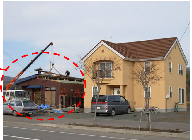
写真 35 屋根が飛散した住宅と健全な住宅
