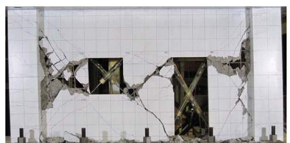
(d) 1/100rad. 加力終了時（最大ひび割れ幅 →計測終了）
