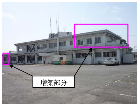
写真 B-48 建築物外観（北側）
