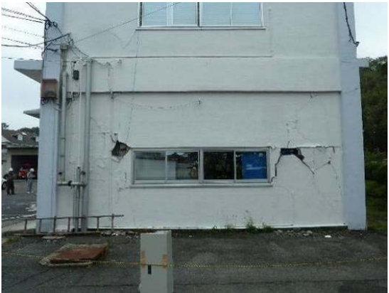
写真 B-40 コンクリートブロック造壁の破壊（X4 構面）
