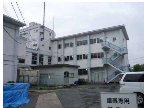
写真 B-32 建築物外観（北面）
