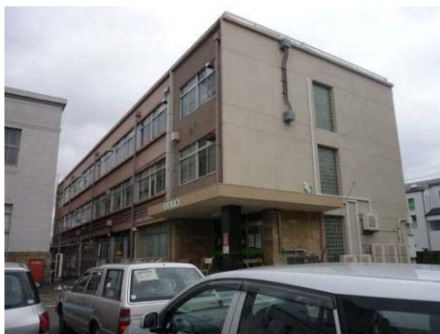
写真 B-25 建築物外観（東面）
