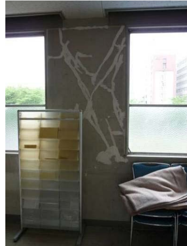
写真 B-24 方立て壁の被害内観 (雨漏り防止のための暫定的な補修)
