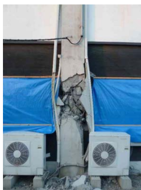
(b) 短柱せん断破壊
