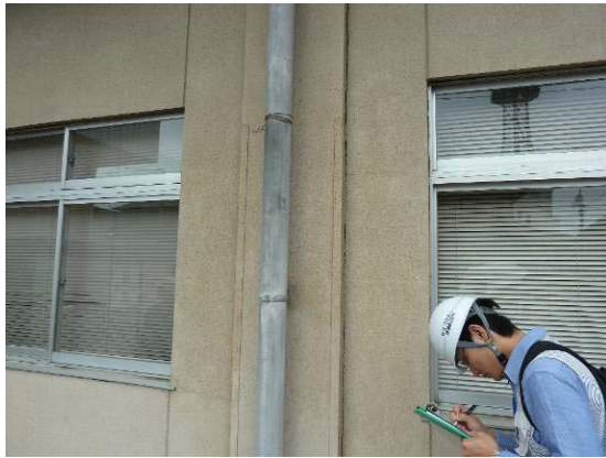
写真 B-19 無損傷の袖壁付き柱 (1 階)
