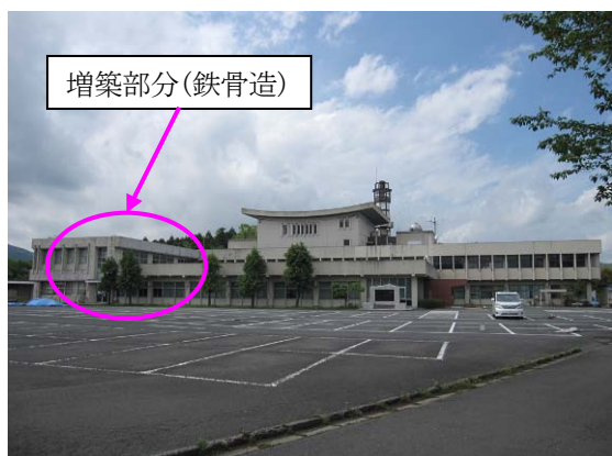
写真 B-41 建築物外観（南側）
