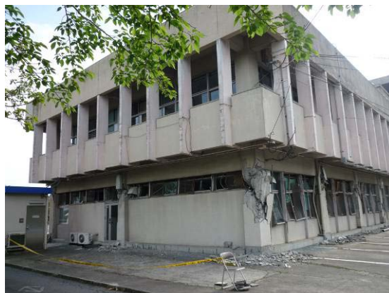
写真 B-42 建築物外観（東側）
