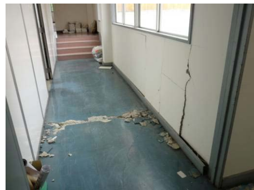
写真 B-5 建築物 B' との接続部（2 階）
