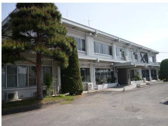
写真 B-47 建築物外観（南側）
