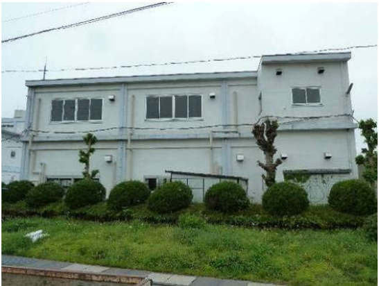
写真 B-38 建築物外観（北面）
