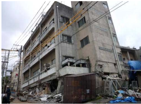
写真 5. 2. 1-1 1 階の層崩壊
