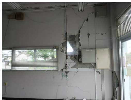
写真 5.2.2-10 コンクリートブロック造壁の被害（建築物 H）
