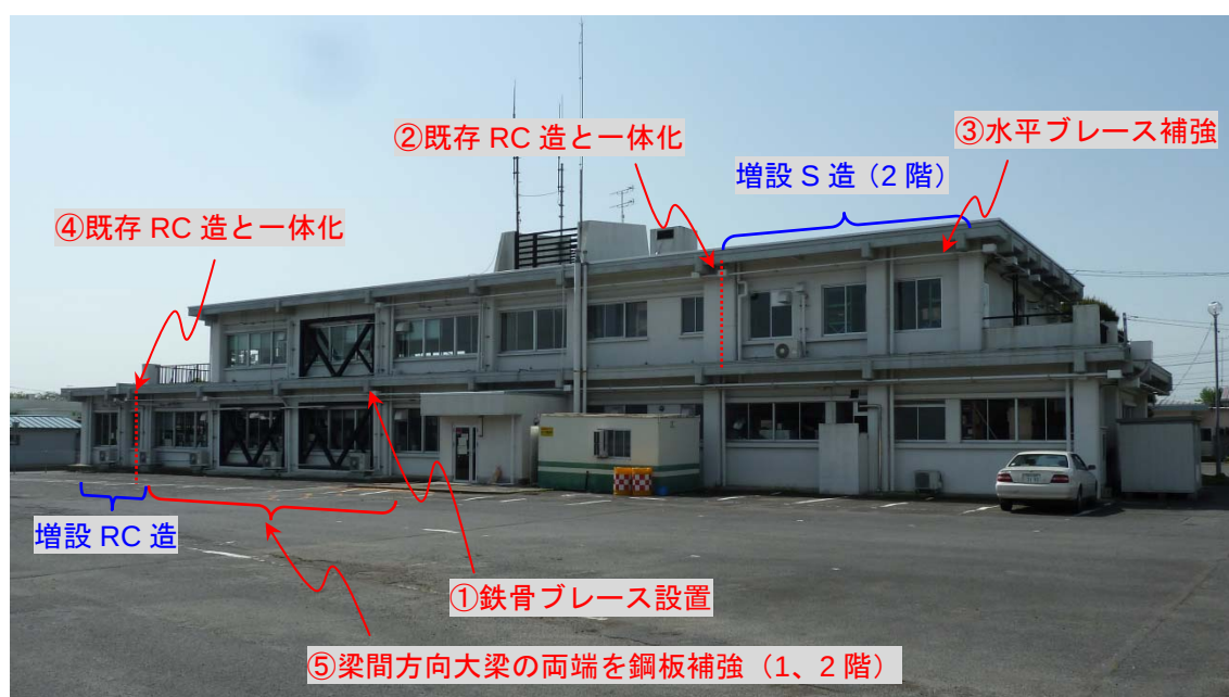
写真 5.2.3.3-1 本建築物外観及び耐震補強概要
