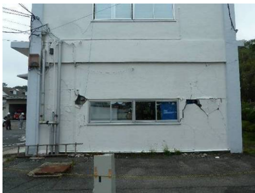
写真 5.2.2-10 コンクリートブロック造壁の被害（建築物 H）
