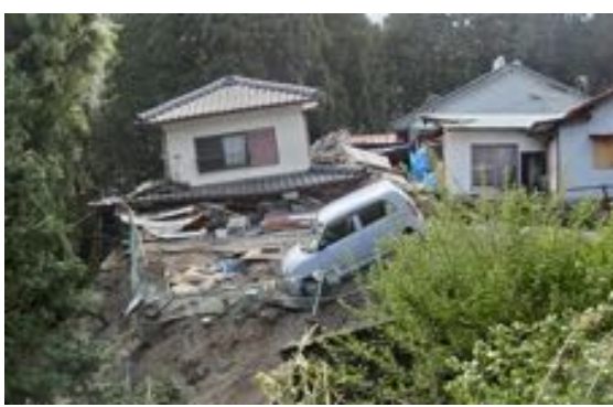
写真 5.3.4 国道 325 号沿いの倒壊家屋
