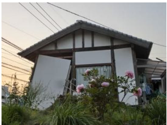
写真 6.2.2 壁が外れただけの家屋（左：4/15）が倒壊した（右：4/16）例
