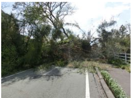
写真 5.2.3 写真 5.2.2 の側の道路閉塞
