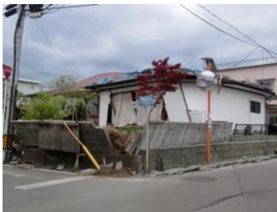
写真 6.2.1 建具が外れただけの住宅（左：4/15）が大きな傾斜になった（右：4/16）例
