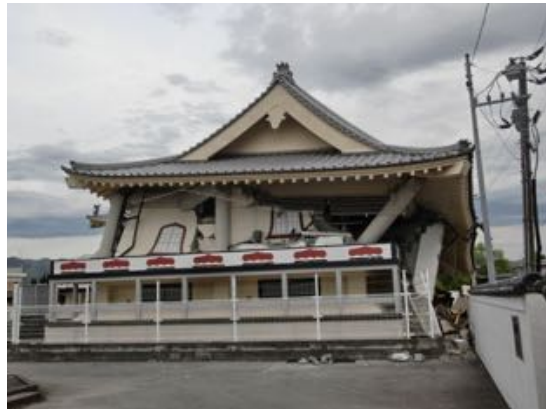
写真 5.7.12 大破した RC 造の社寺
