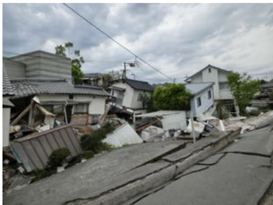
写真 5.7.1 路盤崩壊と倒壊家屋
