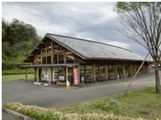
写真 5.4.1 無被害の道の駅清和文楽邑物産館
