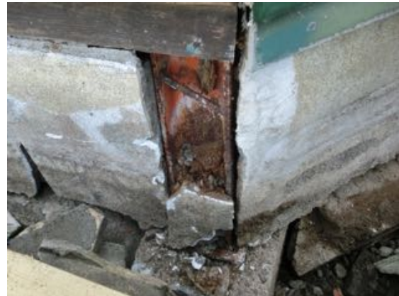
写真 5.2.12 写真 5.2.10 の建築物の一部に 使用された鋼材（木部が腐朽で喪失）
