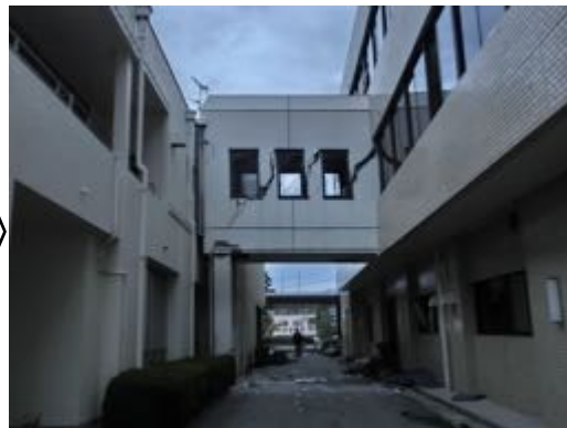
写真 6.1.4 渡り廊下の軽微な損傷（左：4/15）と大きなひび割れ（右：4/16）
