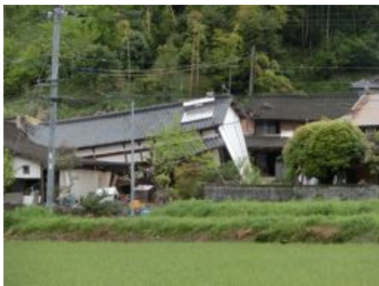
写真 5.6.3 納屋の倒壊
