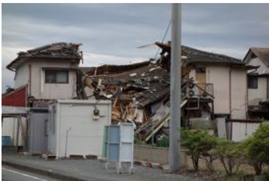
写真 5.6.8 中央部のみが破壊した店舗併用住宅(左)と震災前の姿（右：Google マップから引用）
