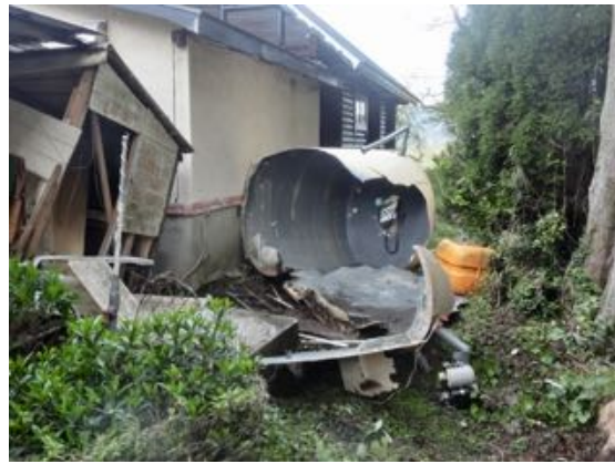
写真 5.1.14 貯水タンクの転倒・破壊
