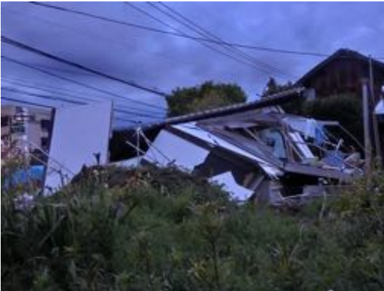
写真 6.2.2 壁が外れただけの家屋（左：4/15）が倒壊した（右：4/16）例
