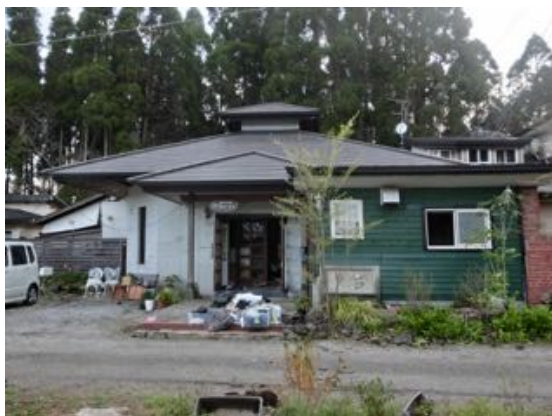
写真 5.1.1 宿泊施設の RC 造食堂棟
