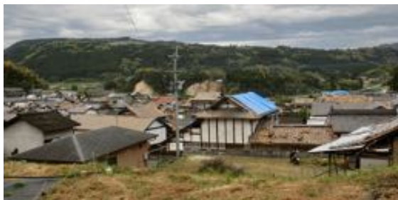
写真 5.6.1 屋根の被害が多い益城町小谷
