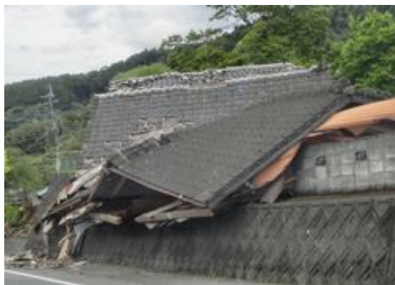
写真 5.5.4 倒壊した家屋
