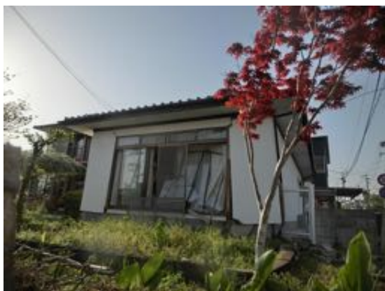
写真 6.2.1 建具が外れただけの住宅（左：4/15）が大きな傾斜になった（右：4/16）例
