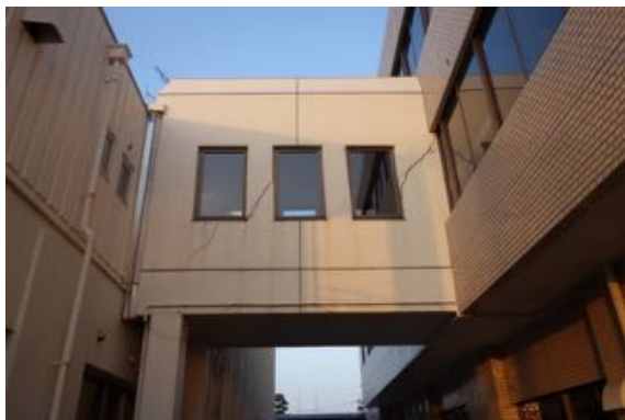
写真 6.1.4 渡り廊下の軽微な損傷（左：4/15）と大きなひび割れ（右：4/16）
