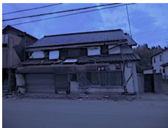
写真 6.2.3 残留変形が大きくなった店舗併用住宅（左：4/15、右：4/16）
