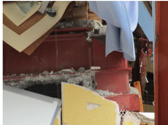
写真 4.2.1.21 柱梁接合部
