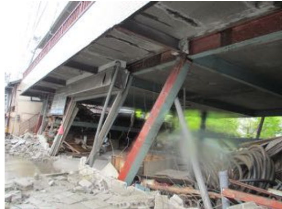
写真 4. 2. 1. 30 1層の層崩壊
