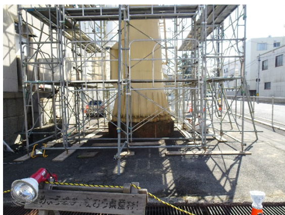
(c) 鋼製煙突の下部
