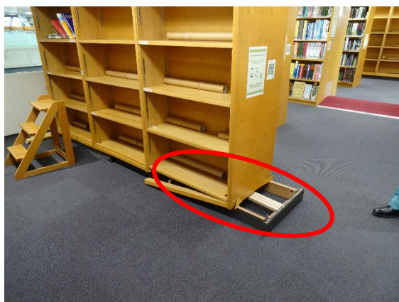
(c) 本棚の被害（赤丸部）
