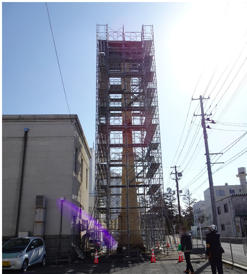
図 4.2.2 鋼製煙突 B 外観
