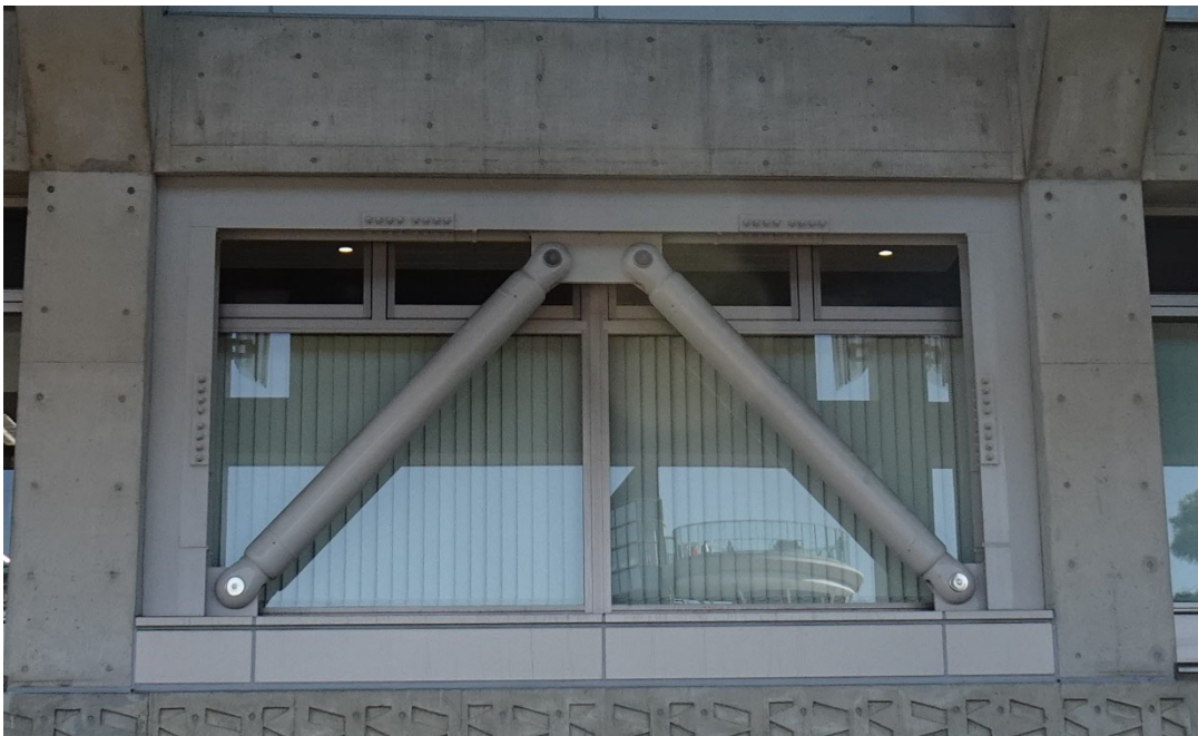
図 4.1.3 鉄骨ブレースで補強された 1 階の架構
