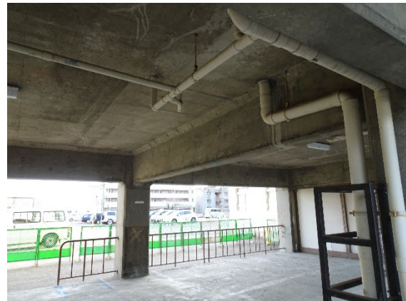
(b) ピロティ構面の梁
