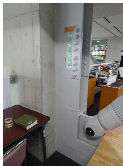
(b) 枠付き鉄骨ブレース
