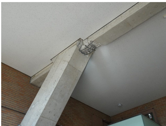
(a) 3 階梁の破壊
