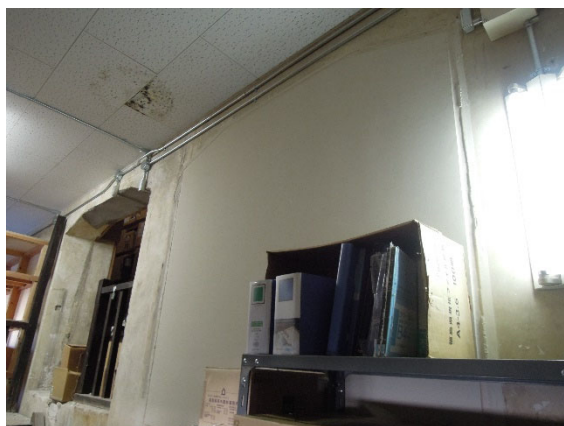
(a) 建築物 3 階増打ち壁
