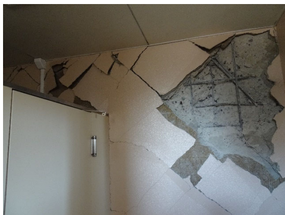
(a) 南側妻構面耐力壁
