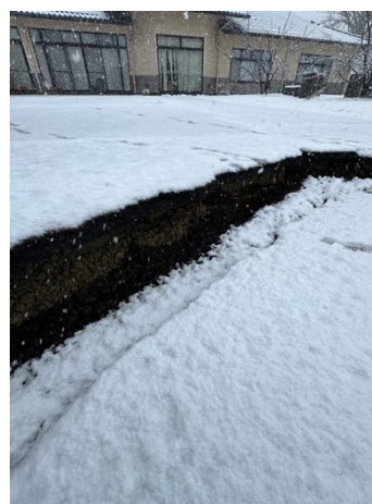
図 5.4.3 正院公民館付近の地割れ
