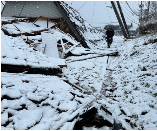
図 5.4.6 周辺の建築物の被害状況
