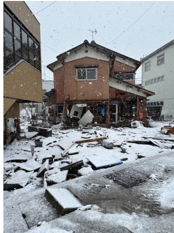
図 5.3.2 開口部の損傷
