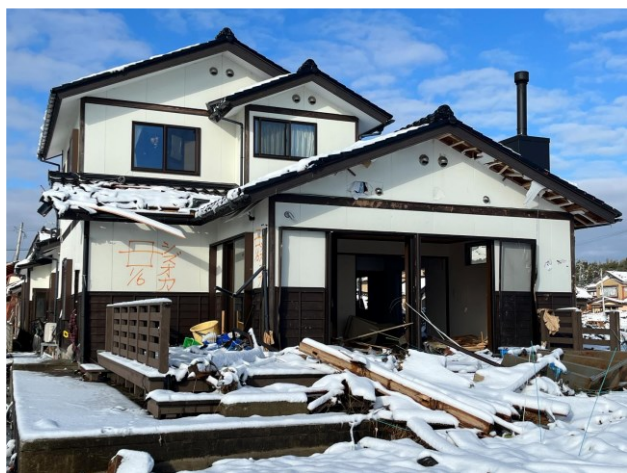
図 6.2.7 流失を免れた建築物(2)
