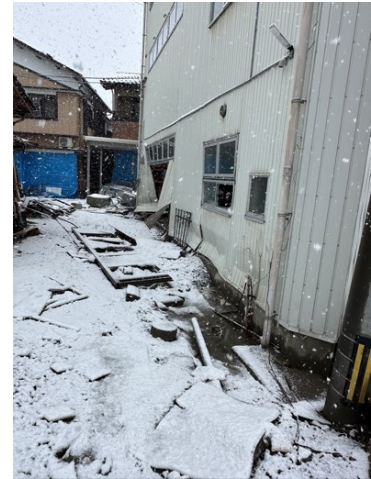
図 5.3.3 外壁の損傷
