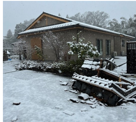
図 5.4.9 住宅に隣接した門の倒壊
