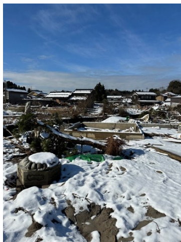
図 6.3.2 流失した住宅(2)
