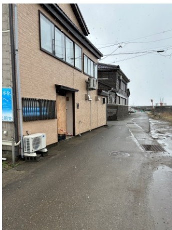
図 4.1.4 床上浸水したと見られる住宅周辺
