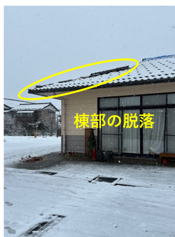
図 5.4.2 棟部の被害
