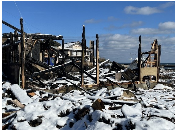
図 6.3.15 火災被害状況(1)
