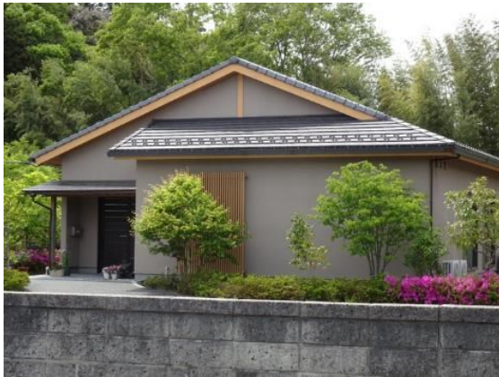
図 5.4.8 令和 5 年 5 月の地震後の状況 (F 形瓦) 6)
