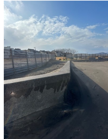
図 4.2.5 損傷のない防砂柵 (海側に堤防あり)
