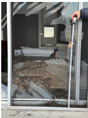
図 6.1.4 痕跡高さとガラスの被害
