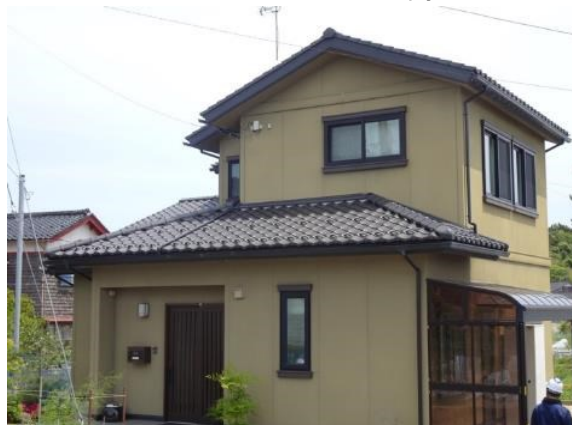
図 5.4.5 令和 5 年 5 月の地震後の状況 (J 形瓦) 6)
