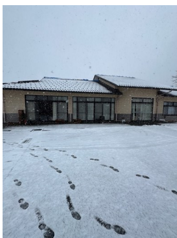
図 5.4.1 正院公民館の被害状況
