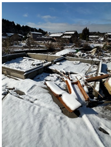
図 6.3.1 流失した住宅(1)
